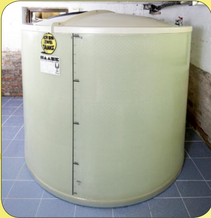
Weitere Vorteile: Die bei Batterietanks fehleranfälligen Verbindungen sind nicht notwendig und das Befüllen kann schneller und trotzdem sicher vonstatten gehen.
