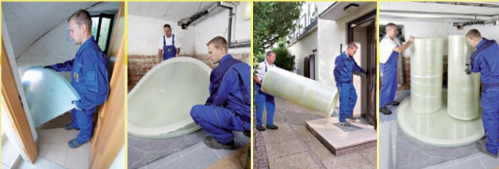
Der Haase-Kellertank wird in Einzelteilen geliefert und erst im Tankraum montiert. Die Wandung ist aufgerollt wie ein Teppich, Boden und Deckel sind - wenn nötig - halbiert. So passt er durch jede Tür, sogar durch kleinste Luken.
